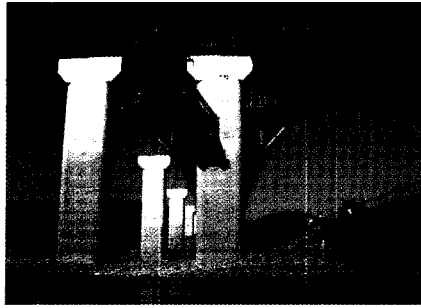
(a) 전방 P/B 설치
