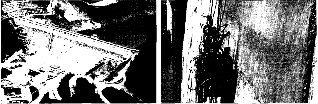
그림 1. Mitaka 댐의 보수 (스프레이 공법에 의하여 타설된 20mm 두께의 ECC 보수층)
