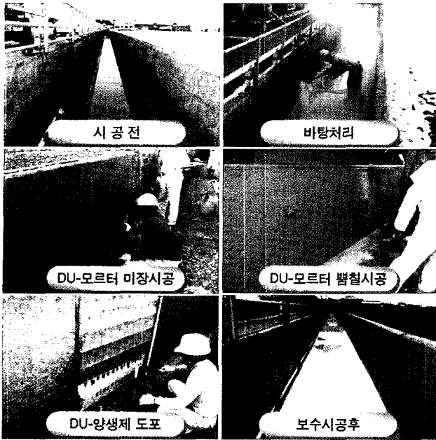
사진 5. DU-모르타르 라이닝 보수공법의 적용사례
