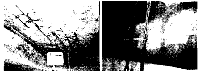
(a) 보강근의 부식 (b) 피복콘크리트의 박락
