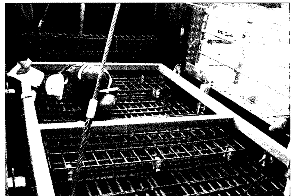
그림 8. 가이드 빔을 설치 후 철근망 삽입
