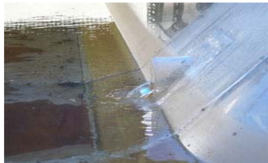
그림 7. 수로에 설치된 토구 모습
