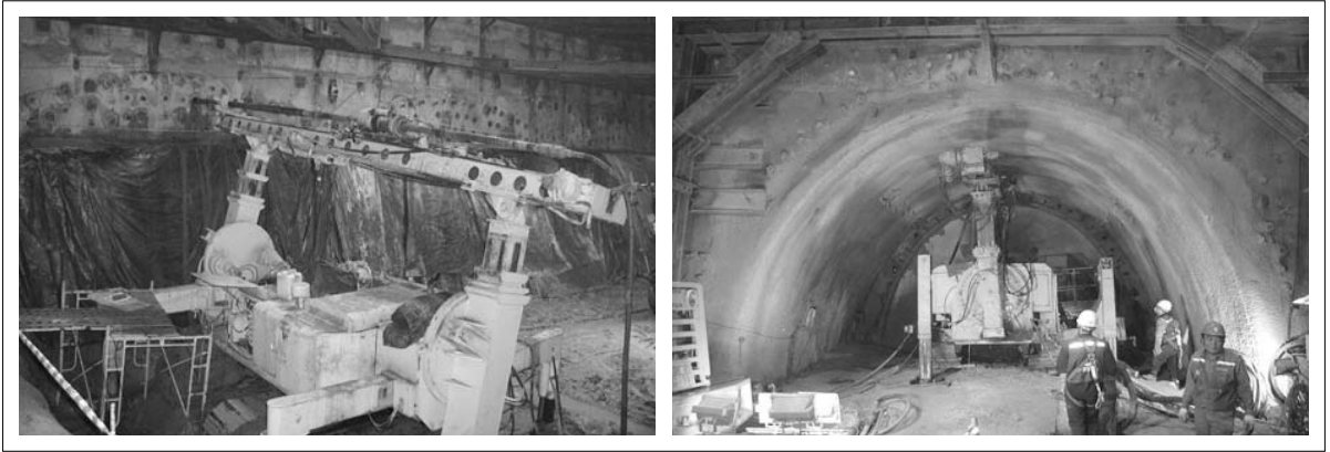
그림 7. 3-Arch 터널 보강공 시공
