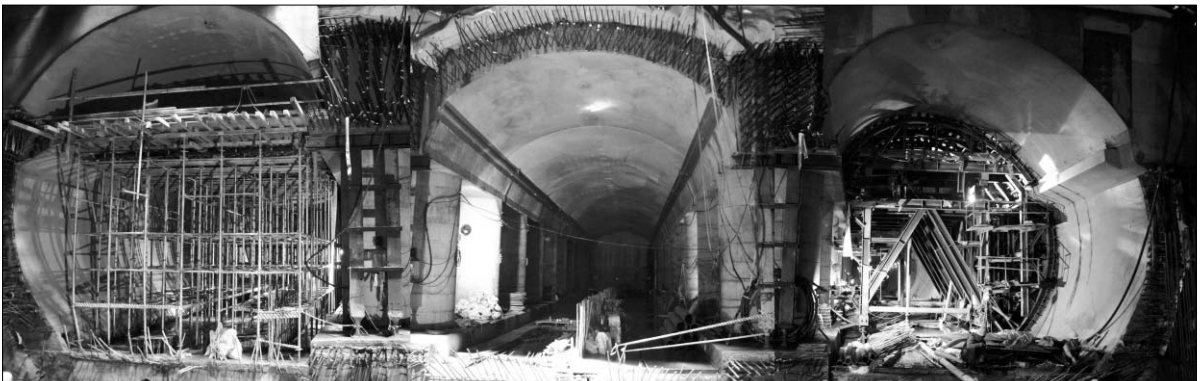
그림 8. 3-Arch 터널 전경
