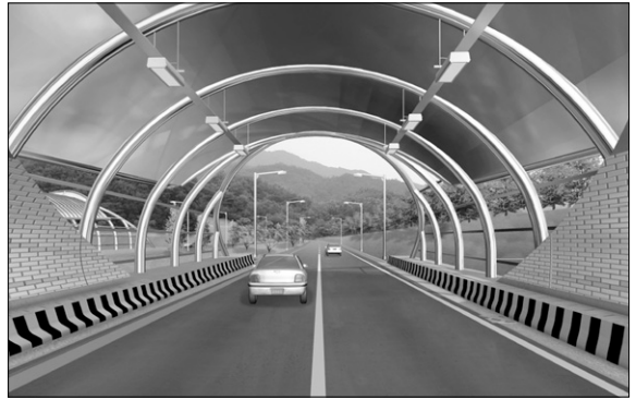
그림 2. 캐노피가 설치된 터널
