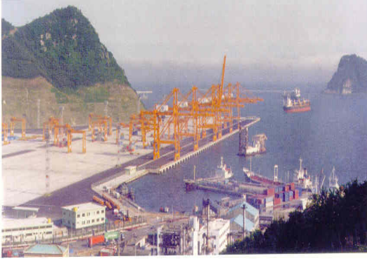
그림 1. 신선대부두 축조공사 Fig. 1 Built a new big port business
