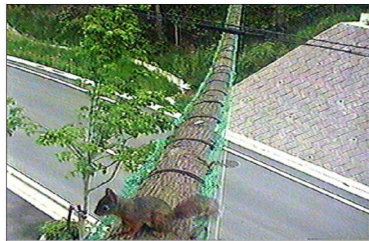
(b) 도로를 가로걸러 설치된 횡단육도로
