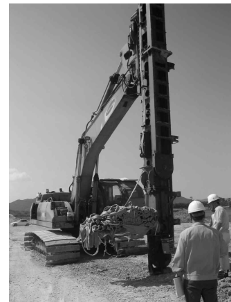
그림 3. 천연섬유배수재 시공 사진
