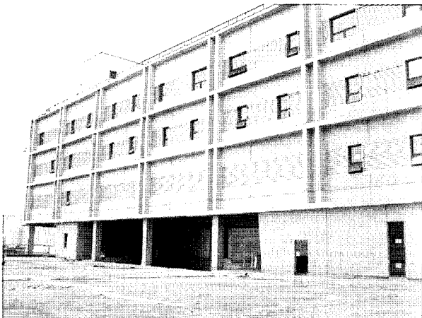
사진 6. 노출콘크리트 시공현황(강의동 C동)
