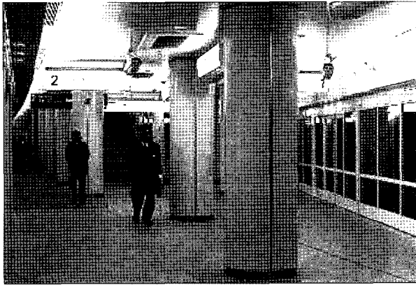
〈그림 2〉스크린도어가 설치되어 있는 지하역사 승강장
