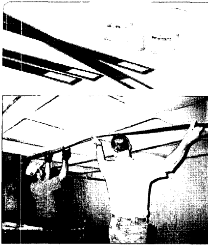
Figure 16. CF strip 및 이를 이용한 시공 모습.
