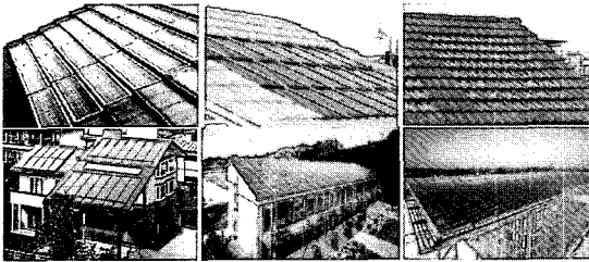
그림 8. 건물부착형 PV시스템 적용 사례1(평판형 지붕).
