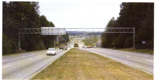
그림 1. 가변정보판이 설치된 트러스 형식의 지주구조물
