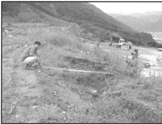
Figure 6. 배면토 유실 흔적(상부).
