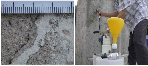
(a) 균열폭 측정
