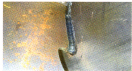
그림 7. 종리브·횡리브 용접부 개선 형상 - 반대편 백가우징 상태
