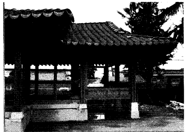
[그림 9] 공사 당시 최명희문학관
