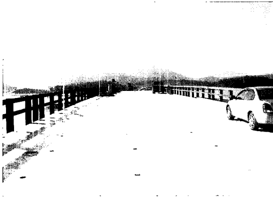
사진 9 광양항 진입도로 교량의 복합소재 바닥판 설치 완성 모습
