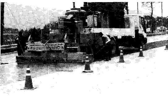
사진 2. 개발한 주입장비에 의한 시멘트 페이스트의 주입
