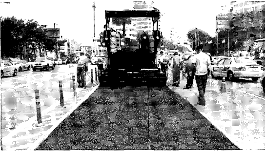
사진 1. 모체 아스팔트 혼합물의 포설
