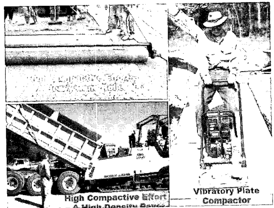
그림 11. 투수 콘크리트 포장의 다양한 시공
