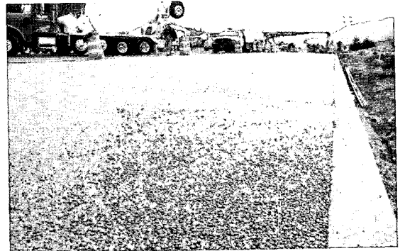
그림 10. 투수 콘크리트 포장 전경
