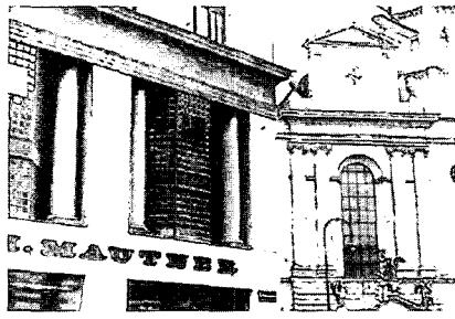
<그림 11> House on the Michaelerplatz와 Michaelerkirche의 상세 전경
