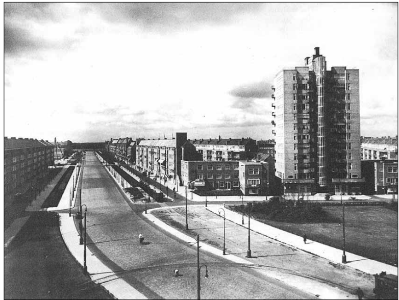
그림 5. 스타, 민영집합주택(암스테르담, 빅토리 광장), 1929~32. 암스테르담 최초의 고층건축물인 이 집합주택은 '1915년 베를라헤가 암스테르담시 남북확장계획안에 기초한 도시경관의 미학적 강조를 부가한다'라고 하는 요구에 기인하고 있다. 이 계획부지는 도로의 주요 교차점에 있었다. 뉘이꺼의 고층건축은 생활공간이 남향으로 되어 있다는 사실로부터 매스와 공간의 구성에 영향을 주고 있다. 스타의 집합주택에서 각 세대는 베를라헤의 직선축을 따라 도시경관을 형성하고 있다. 뉘이꺼는 이와 같이 반복적으로 건설되는 것에 비판을 하였고, 또한 '거의 모든 경제적 법칙에 어긋나는 것이 아닌가'라고 느끼고 있었다. 이 집합주택은 각층에 2세대로 구성되어 있으며 전부 24세대이다. 이 정도의 규모에 2대의 엘리베이터가 설치되어 비판의 대상이 되고 있다.
