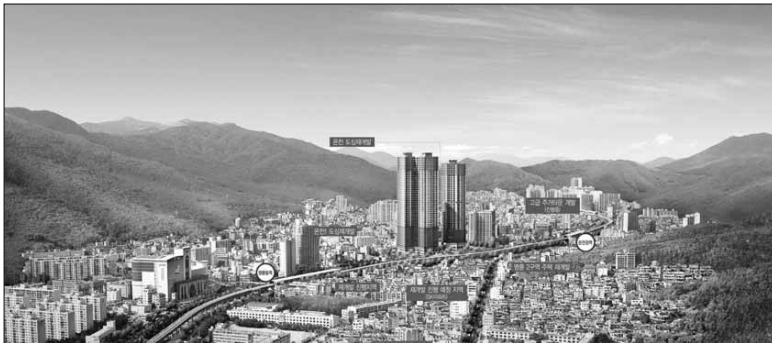
부산 비산 아스타 (전경)
