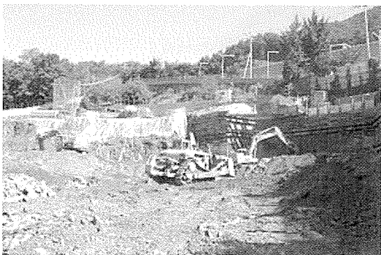
사진 1. 굴착 및 노면정리에 이용되는 건설기계
