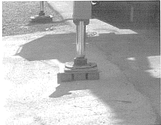
받침목을 고인 아웃트리거의 양호한 설치 상태 사진 3. 트럭크레인의 아웃트리거 설치 상태
