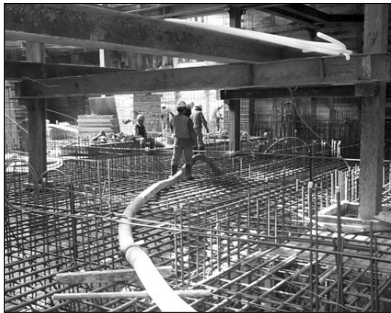
지하 3층 바닥 콘크리트타설
