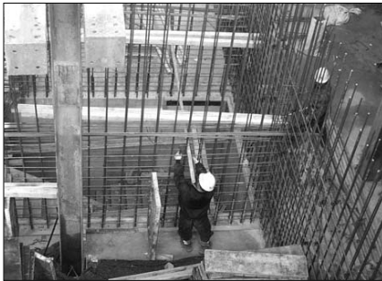
지하 3층 ELEV벽체 철근배근
