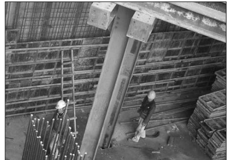
지하 3층 합벽거푸집 조립
