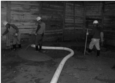
남측부 버림 콘크리트 타설
