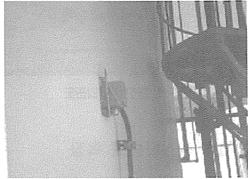
[그림 6] 암모니아 누출 감지 센서
