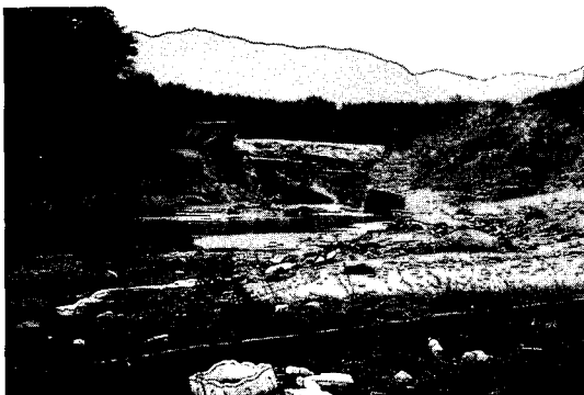
사진 9. 장현저수지 물넘이 붕괴
