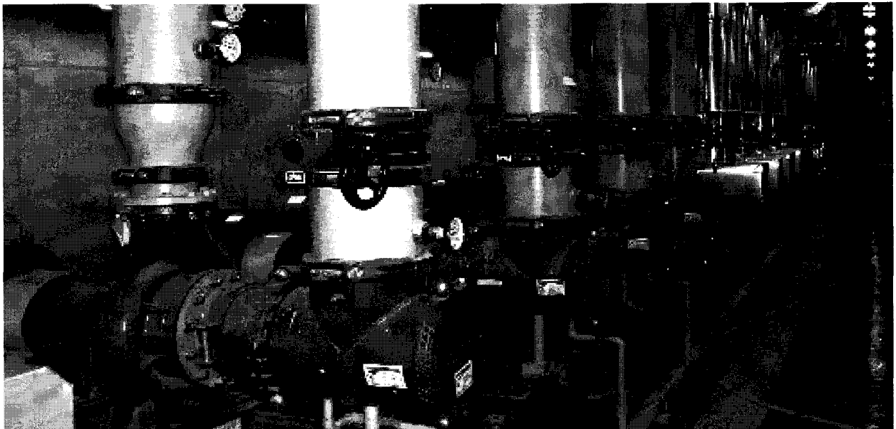
기계실 냉각수 펌프
