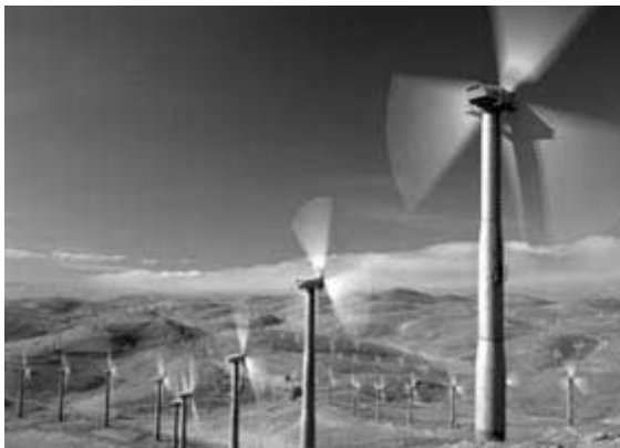
그림 2. 미국 캘리포니아 풍력발전단지 전경
