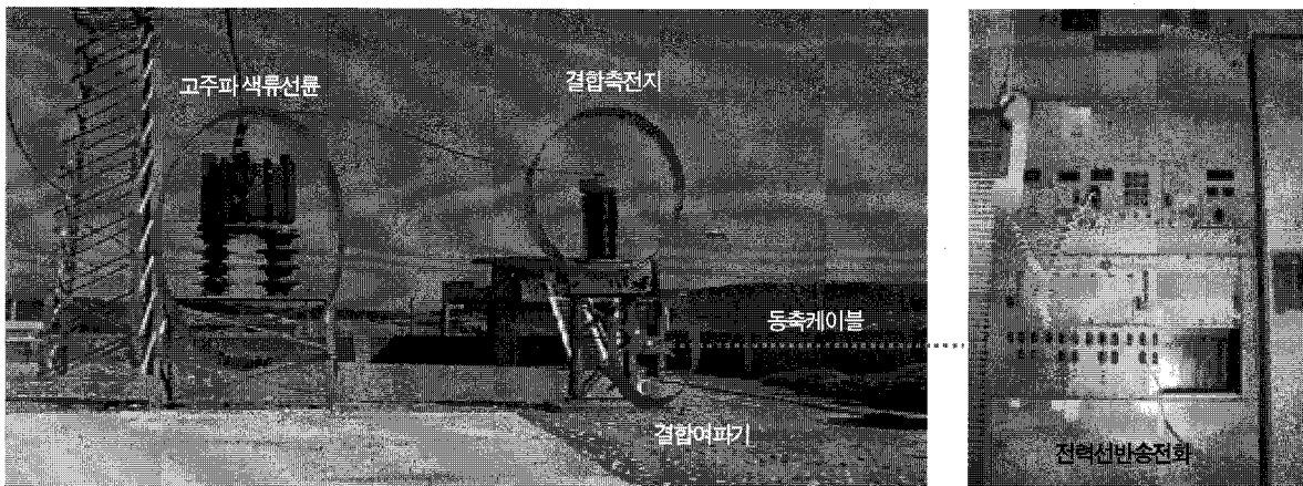
■ 그림 1 _ 초창기 송전선 전력선반송(PLC) 구성
