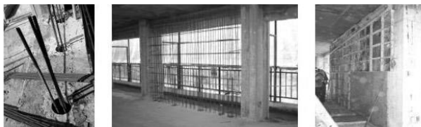
a) 연결 철근용 코어 b) 신설 벽체 철근배근 c) 콘크리트 타설/양생
