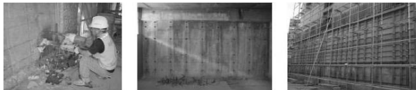
a) 앵커 홀 천공 b) 앵커 시공 c) 갱폼 설치
