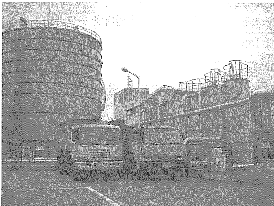
그림 2. 250kW MCFC 2호기 설치 위치 (서울 탄천환경)
