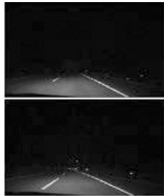
일몰 → 부안 16.5k(군산방향) 중단경사 +1.75%, 편경사 +3.7% A=500m 원형곡선 구간
