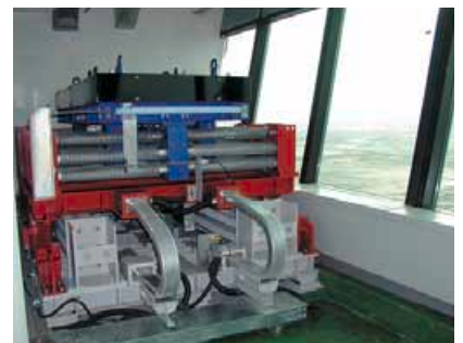
〈그림 9〉 인천 국제공항 관제탑에 장착된 HMD는 바람이나 지진에 의한 진동을 감지, 컴퓨터에 의해 진동을 제어하도록 되어 있다.
