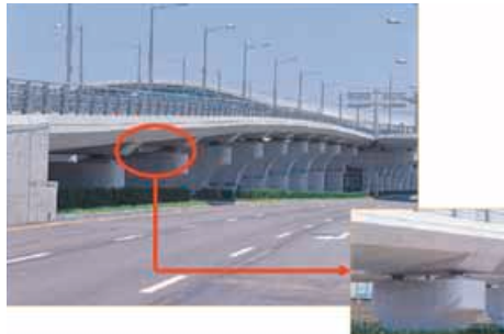
〈그림 3〉 (왼쪽) 충남 천안의 (주)유니슨기술연구소 건물에 설치된 지진격리장치(오른쪽)와 인천 국제공항 고가교에 설치된 지진격리장치
