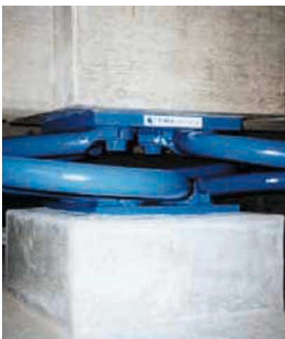
〈그림 5〉 고리 모양 금속봉의 찌그러짐을 이용한 감쇠기(Yield Damper). 지진이 오면 변형이 발생, 에너지가 소산된다.
