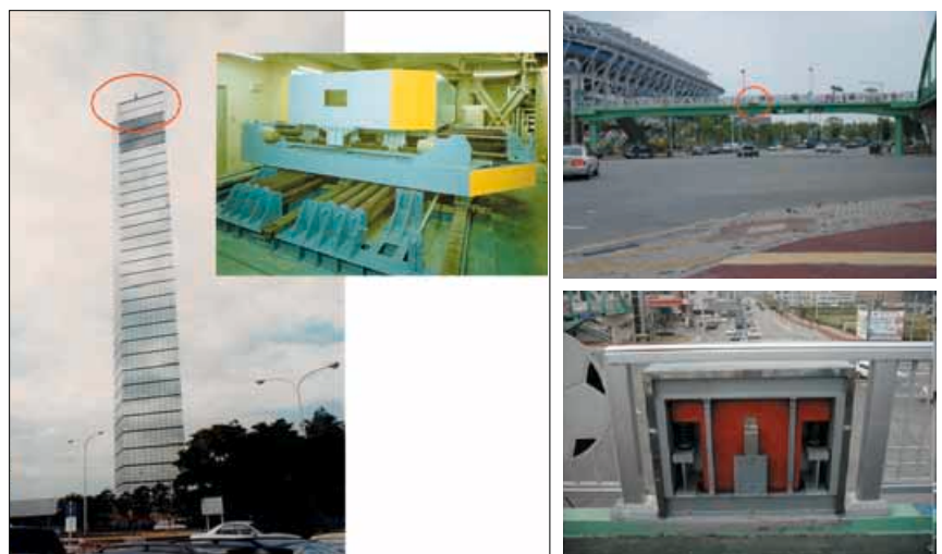
〈그림 7〉 (왼쪽)일본 Chiba Port Tower에 설치된 TMD는 강한 바람에 건물이 좌우로 흔들리는 것을 막아 준다. (오른쪽) 대전 월드컵 경기장 옆 육교에 설치된 TMD는 육교가 아래 위로 출렁이는 것을 줄여준다.
