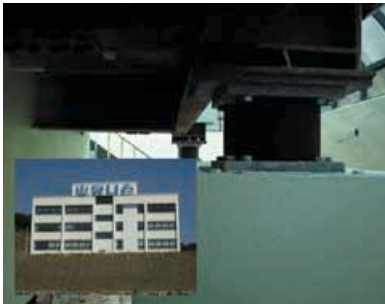
〈그림 3〉 (왼쪽) 충남 천안의 (주)유니슨기술연구소 건물에 설치된 지진격리장치(오른쪽)와 인천 국제공항 고가교에 설치된 지진격리장치
