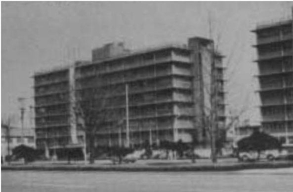
공조설비를 갖춘 현대식 건물의 대표적 사례로 꼽히는 USOM청사(전 경제기획원 건물)
