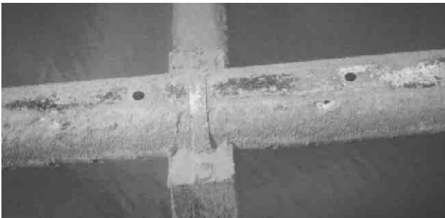
그림 4 침전지 잠수형 오리피스 스크 부착 사진
