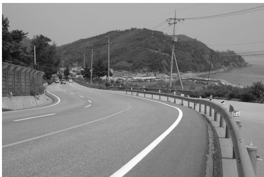
국도 7호선(강원 삼척시 원덕읍 임원리)
