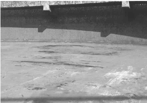
그림 2) 스크레퍼 브러시형 Rubber 설치 전 불규칙한 바닥면
