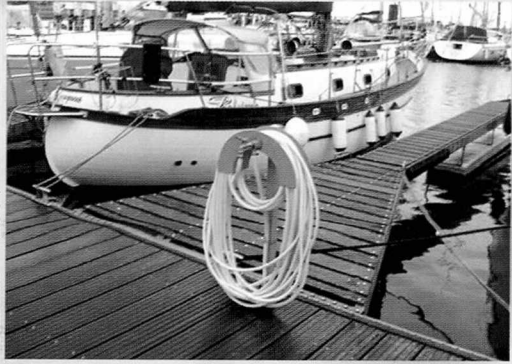
≧ 뉴포트항 - 썩지 않는 나무를 이용한 접안시설을 구축하고 있다.(스테인리스 볼팅)
