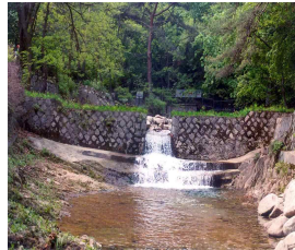
사진 2. 바닥막이 천단부에 식생매트를 깔고 녹화시킨 후의 계곡 경관.
