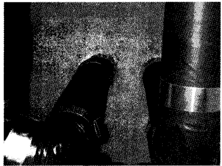
그림 12. Sleeve through wall
