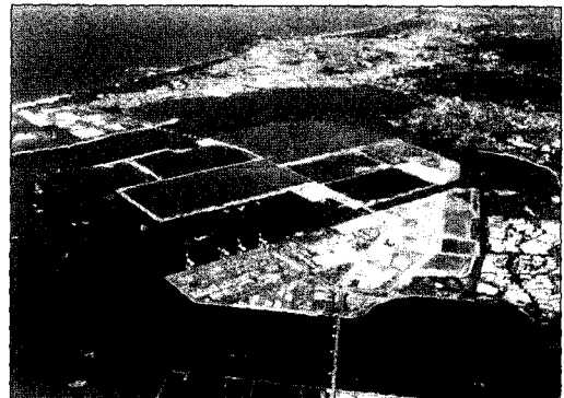
사진 1. 후쿠오카시의 항만프로젝트, Island City(중앙)와 잠帷 Park Port(앞) (촬영:1999.10)
