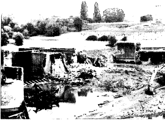
그림 4. Maison-Rouges Dam 철거 현장 (European Rivers Network, 2005)
