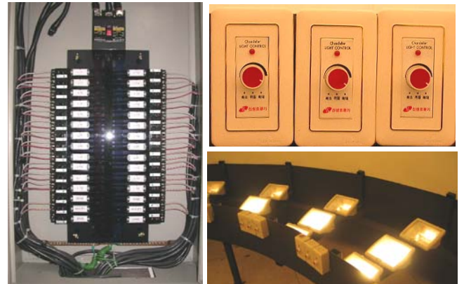
그림 8. 조명제어 시스템과 밝기가 조절된 모습
