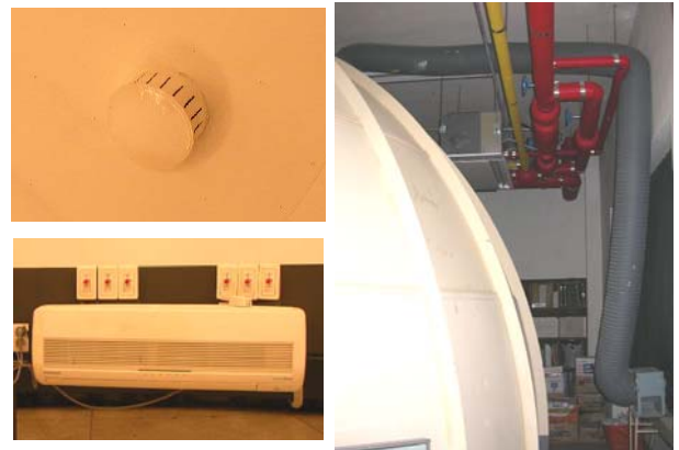
그림 9. 인공천공돔의 공조시스템
