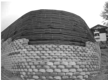
(a) 잔디가 발아되기 전(시공 직후)
