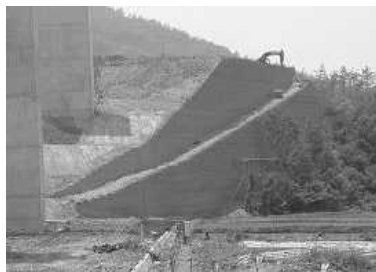
그림 3 보강토옹벽 시공 상태
