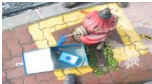
FIGURE 11. Data logger를 이용한 압력측정
